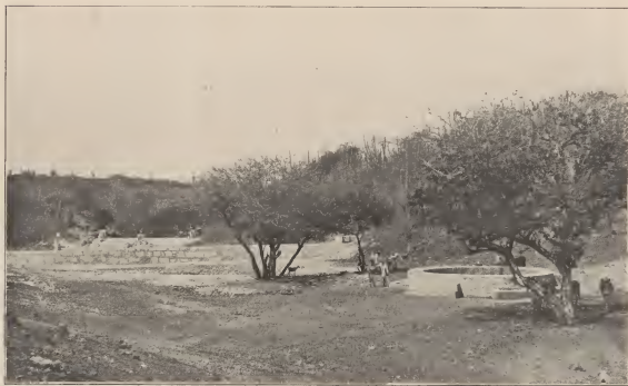
187. WATERPUTTEN BIJ RINCON
